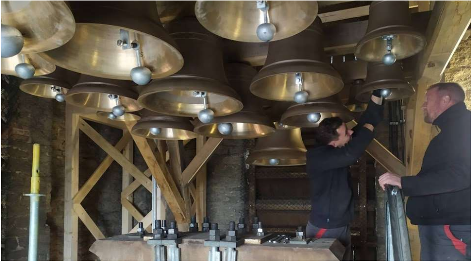
Mitarbeiter der Firma Eijsbouts installieren das neue Carillon über der großen Ludgerus-Glocke
